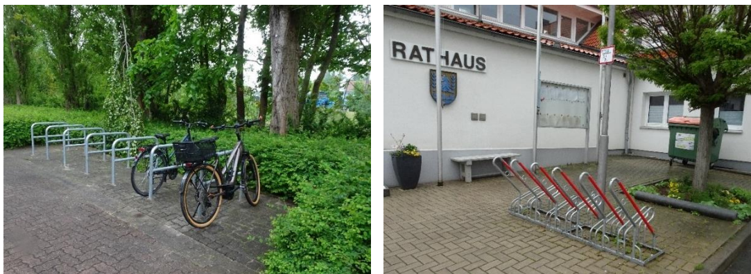
Abb. 6-1: Anlehnbügel mit Querverstrebung am Rathaus Ilsede (links), kombinierter Vorderradhalter am Rathaus Wendeburg (rechts)
