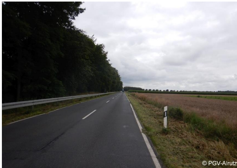
Abb. 5-3: Woltofer Straße (L 321) nördlich Woltorf
